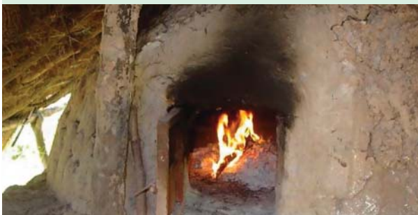
Le four avant les aménagements
