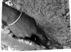
3<sup>ème</sup> étape : Installation d'une bague en orange pour protéger le trou contre l'obstruction par les racines et le sable.
