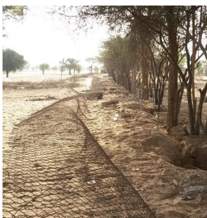
Réhabilitation des clôtures
