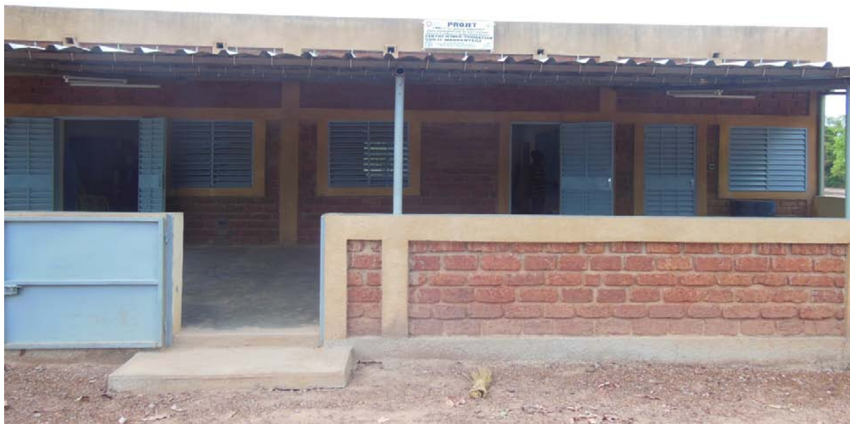
Une vue du bâtiment abritant le centre de formation
