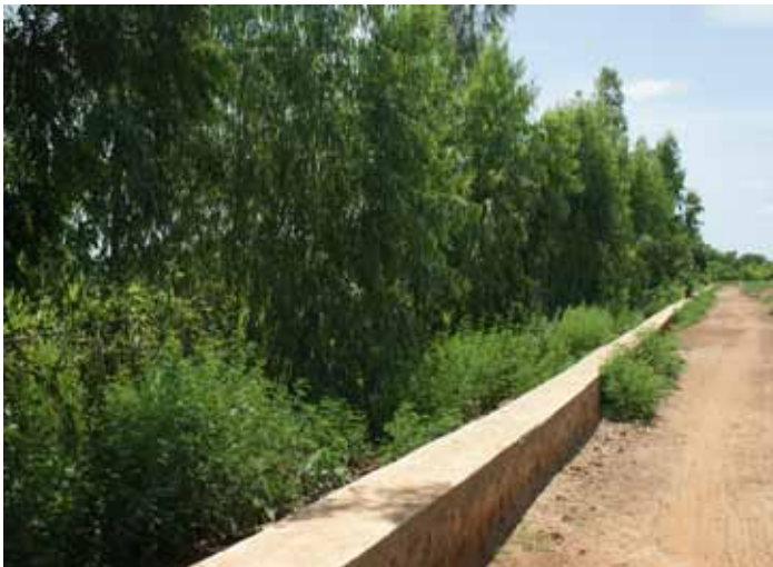
Une digue de retenue
